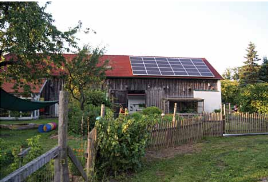
590.000 Euro kostet dieser 200 Jahre alte Dreiseithof. Holz-Alu-Passivhausfenster, kontrollierte Wohnraumlüftung, Vollwärmeschutz, neues Dach, neue Pellets-Brennwertheizung: Auf jedes Detail wurde geachtet. Dank der installierten Fotovoltaikanlage mit einer Leistung von 5,70 kWp ist der Bauernhof energieautark.
