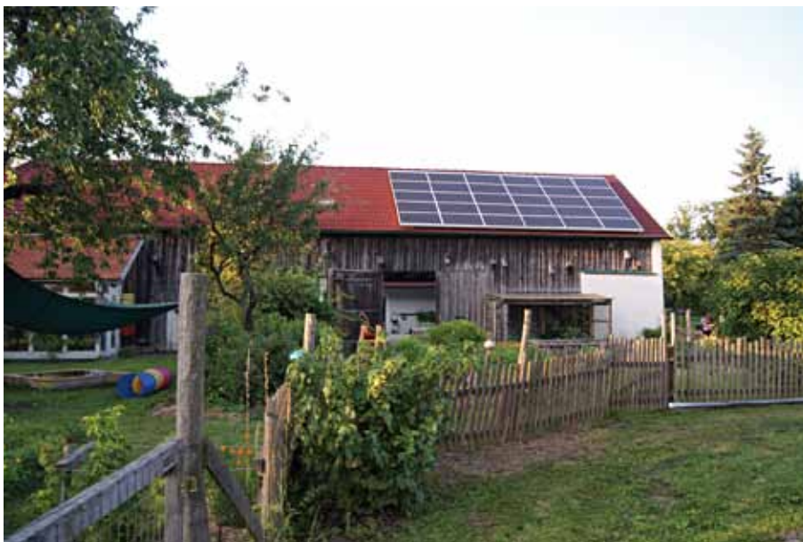
590.000 Euro kostet dieser 200 Jahre alte Dreiseithof. Holz-Alu-Passivhausfenster, kontrollierte Wohnraumlüftung, Vollwärmeschutz, neues Dach, neue Pellets-Brennwertheizung: Auf jedes Detail wurde geachtet. Dank der installierten Fotovoltaikanlage mit einer Leistung von 5,70 kWp ist der Bauernhof energieautark.
