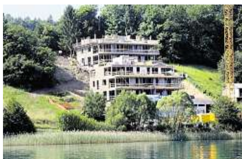
Madile-Baustelle in Dellach. Hier entstehen 16 Wohneinheiten mit eigenem Seezugang
