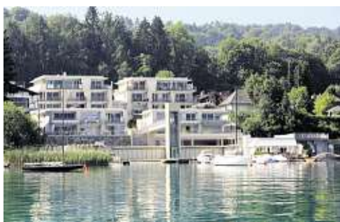
Projekt Seerose von Kollitsch-Müller nahe Velden, fertig seit Juni 2011, eine Wohnung ist noch frei
